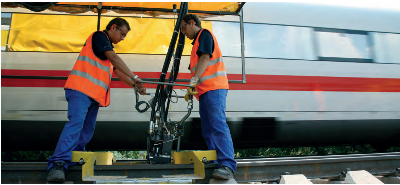
Abb. 1: Hochdruck-Dosiermaschine beim Rohstoffeintrag
