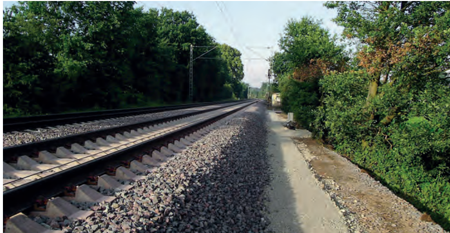
Abb. 8: Das fertige Gleis
