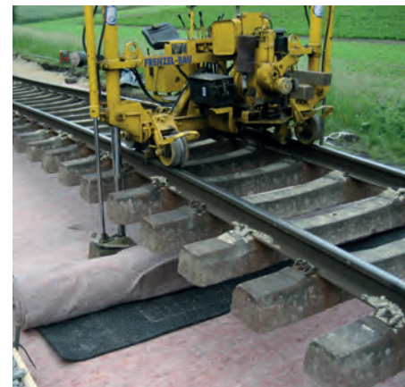
Abb. 3: Einbau der Drainagematten
