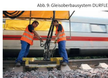
Abb. 9: Gleisoberbausystem DURFLEX
