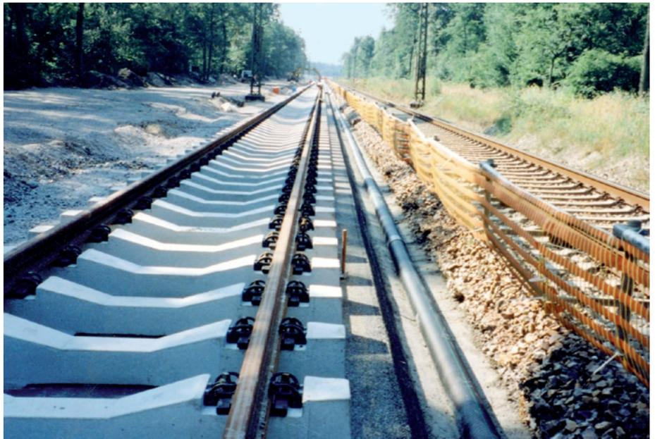
Abb. 1: Spannbetonschwelle Sato 300 auf Asphalttragschicht
