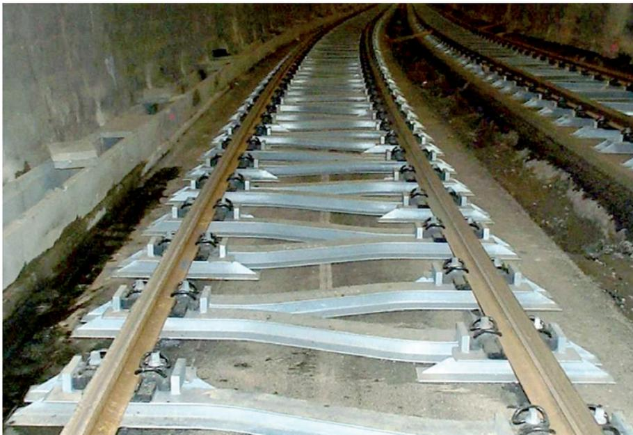
Abb. 3: Y-Stahlschwelle mit Stützpunkt A8
