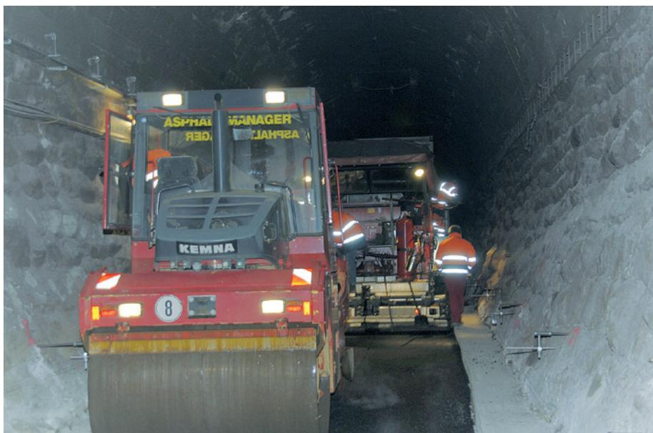
Abb. 6: Straßenfertiger beim Abtasten des Leitdrahtes
