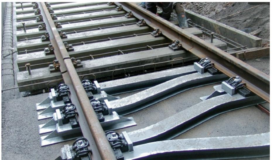
Abb. 2: Übergang Y-Schwelle auf Asphalttragschicht
