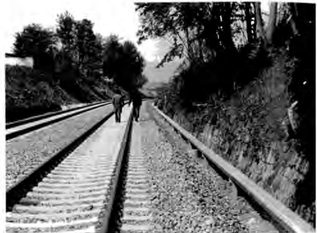
Bild 2: Übergang Stelzentrog-Betonkabelkanal, Stelzentrog Schachteinführung
