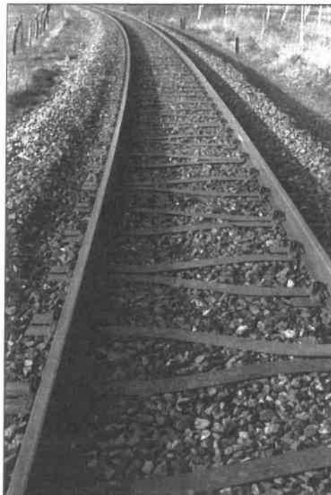
Abb. 3: Y-Stahlschwellenabschnitt
