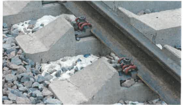
Ausgeschäumte Schottersteine dämpfen den Lärm an der Quelle Ballast stones set in polyurethane foam dampen noise at source
