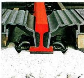
**4** Diese Abbildung zeigt das mit RASKA-Kassettenplatten abgedeckte Gleisbett in der geschlossenen Bauweise „Schallschutz- und Sauberkeitsgleis.“ Die Kassettenoberfläche hat eine eingeformte Splittstruktur.
