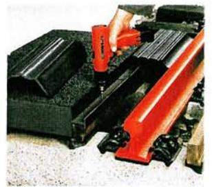
**3** Als nächstes kann der Einbau der Schienenanschlußprofile erfolgen. Mit diesen Elementen wird einerseits eine Komplettabdeckung zwischen Schiene und RASKA-Kassette möglich und andererseits dämpfen sie den Körperschall, der bei Befahren des Gleises entsteht.
