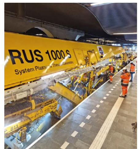
5: Staubreduzierte Gleisbauarbeiten im U-Bahnhof Blaak in Rotterdam
