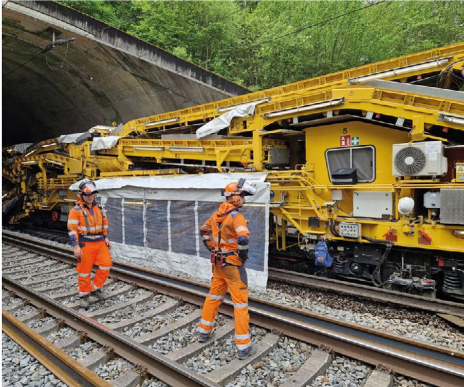
4: Staubreduziertes Arbeiten bei Kassel–Fulda mit der RUS 1000 S
